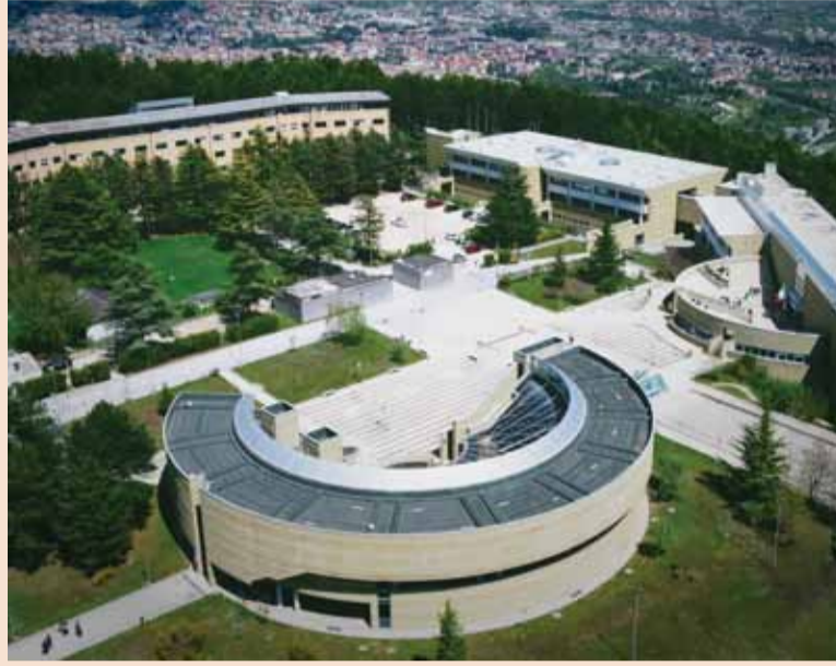
Vista aerea del Polo di Ingegneria a Monteluco di Roio
