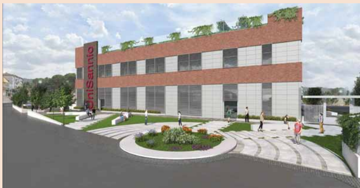
PALAUNISANNIO una moderna palestra in costruzione
